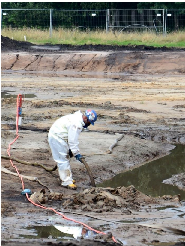
Dort, wo einst Wald und Weide waren, ist nur noch nackte Erde übrig. Mittlerweile konnte zumindest der gesamte durch Erdöl verunreinigte Boden abgetragen werden (Fotos: Jennifer Bahn)
